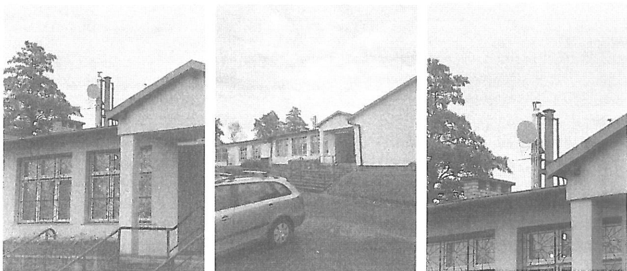
Widok obiektu wraz z zainstalowanym zespołem antenowym
