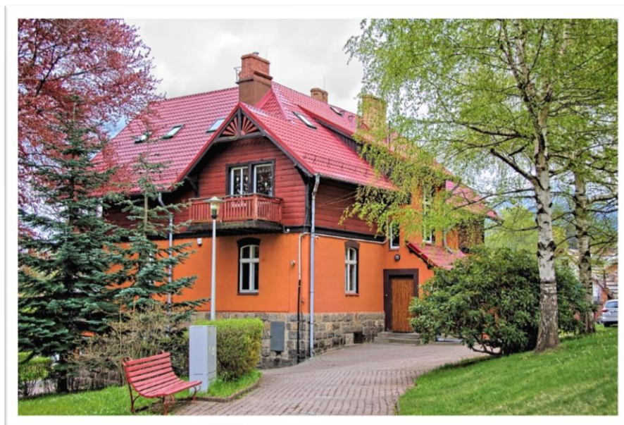
Zdj. 7. Budynek administracyjno-biurowy Domu Wczasów Dziecięcych i Promocji Zdrowia w Szklarskiej Porębie
