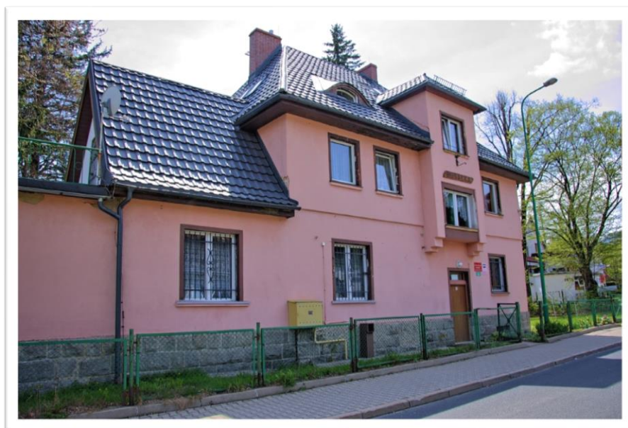
Zdj. 2. Budynek internatu
